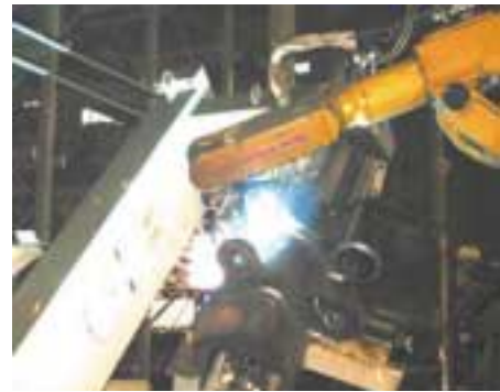
写真1 SE ワイヤ(SEA-50)によるロボット溶接状況〔建設機械〕 Photo 1 Robotic welding with an SE wire (SEA-50) [construction machinery]
