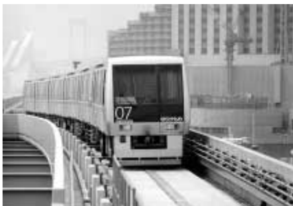
写真1 新交通ゆりかもめ Photo 1 Advanced transit system Yurikamome
