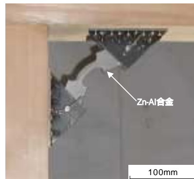
写真 2 木造建物用小型制震ダンパ 1)
