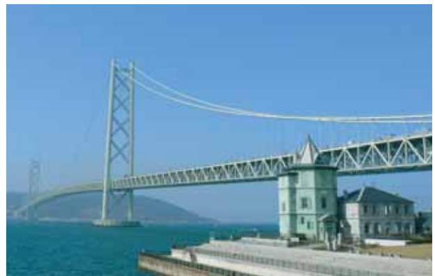
明石海峡大橋
