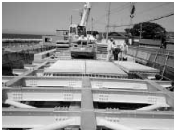
写真1 今別橋架設状況 Photo 1 Construction of open grid deck (Imabetsu Bridge)
