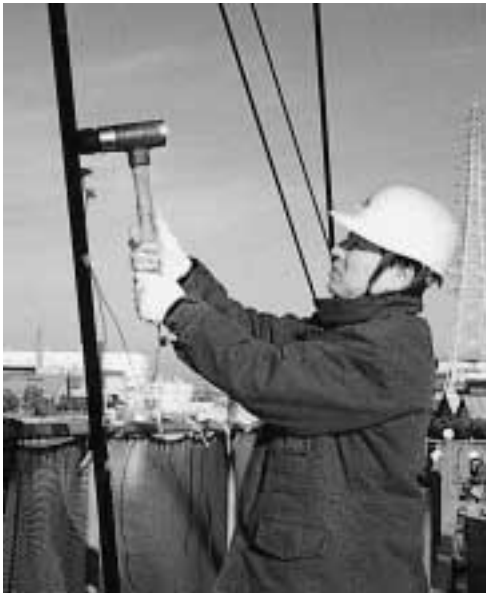
写真4 ケーブル打撃 Photo 4 Hammering
