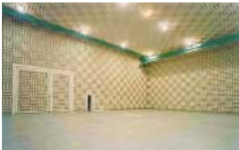
写真1 大型半無響室
