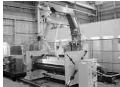
写真1 鉄骨天吊マルチワーク溶接システム全景
