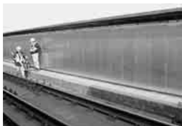
写真5 鉄道でのアルミ微細多孔吸音パネルの試験施工状況 Photo 5 Panel with aluminum material installed along the railway
