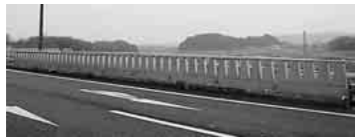
写真7 低層山形遮音壁の設置状況
