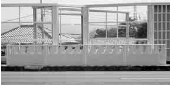
写真10 シースルー型遮音壁設置状況 Photo 10 Placed "see-through" type barrier
