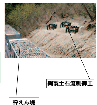
図5 枠えん堤の機能強化奥池(六甲砂防事務所)
