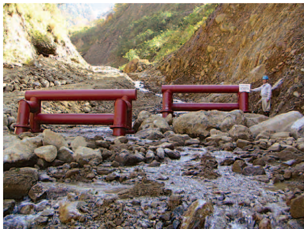
図4 ブルメタル™ の設置状況 Fig. 4 Set up of BULLMETAL™
