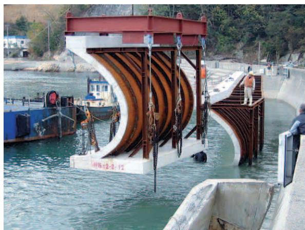
図13 フレアブロック据付 Fig.13 Installation of flare-shaped blocks
