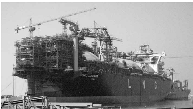
図6 OLT FSRU建設中写真
