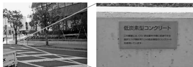
図2 (株)神戸製鋼所新社屋擁壁に適用されている低炭素型コンクリート
