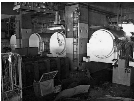
図4 東日本大震災後の保管建屋内 Fig. 4 Storage area after the 2011 Tohoku Earthquake
