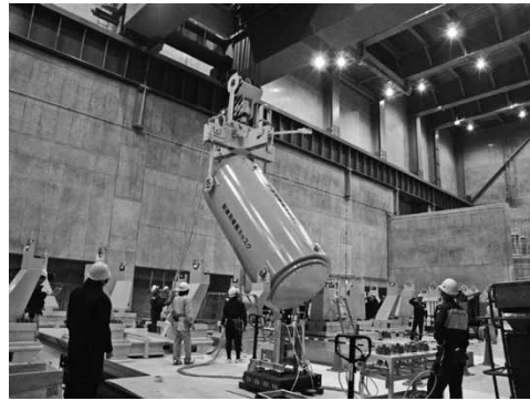
図12 たて起こし作業状況 Fig.12 Cask raising task
