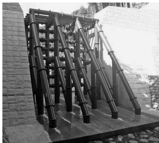
図1 格子形堰堤（下流側より） Fig. 1 KOUSHIGATA sabo dam (from downstream side)
