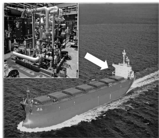
図2 船用バイナリー発電装置搭載船 Fig. 2 Vessel equipped with marine binary power generator
