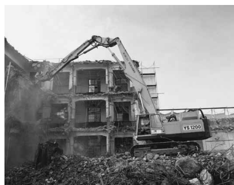
図2 世界初の超ロング解体機：YS1200（1977） Fig. 2 World's first demolition machine with ultra long attachment: YS1200 (1977)
