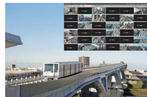
図3 日暮里・舎人ライナーと車両からの遠隔監視画像 Fig. 3 Nippori-Toneri Liner and remote monitoring images from railroad vehicle
