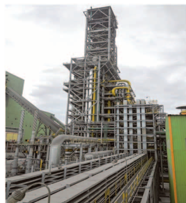
図5 アルジェリア・オランのトシアリ社の製鉄所に建設された最新MIDREX NGプラント (還元シャフト炉 (奥中央) と製鋼工場 (奥左側) にHDRIを搬送するコンベア (手前)) Fig.5 Latest MIDREX NG plant: Tosyali in Oran, Algeria. (Reduction furnace in center with HDRI conveyor to EAF meltshop on left side.)
