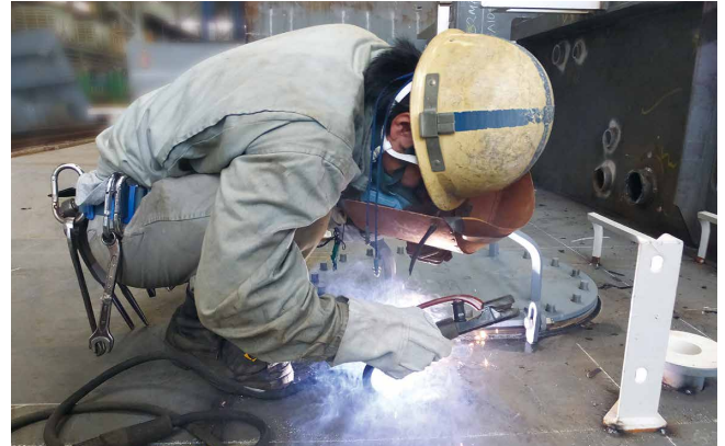
造船所での補修溶接
