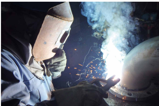
水道管の溶接例
