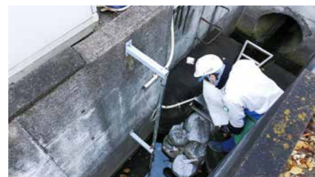
油流出を想定して土嚢や油吸着マットを設置する訓練(神鋼ノース(株))
