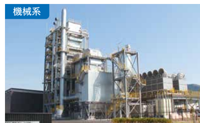
機械系 木質バイオマス発電 バイオマスの有効活用 利用されずに山地残材されていた未利用間伐材をバイオマス燃料としたボイラー発電
