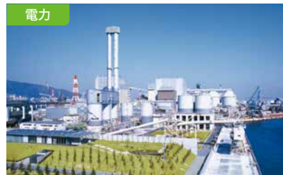
電力 神戸発電所 電力卸供給事業としては国内最大級の発電規模
