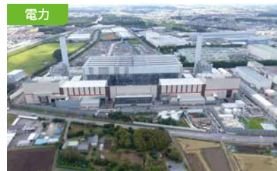
電力 真岡発電所 国内初の大型の内陸型火力発電所
