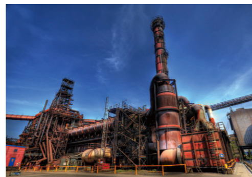
Arcelor Mittal 社ドイツ・ハンブルク工場 既設の直接還元鉄プラント
