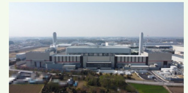
1号機 2019年10月営業運転開始 2号機 2020年3月営業運転開始
