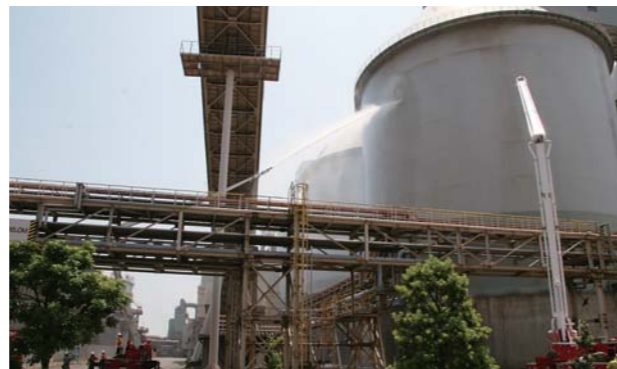
石炭サイロへの冷却放水
