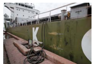
陸上からの船舶への電力供給
