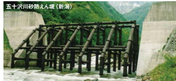
五十沢川砂防えん堤（新潟）
