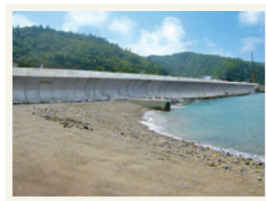
高潮を跳ね返し、津波の勢いも弱めるフレア護岸を西日本8ヵ所に提供。これから日本中の中海辺のまちに広がります。
