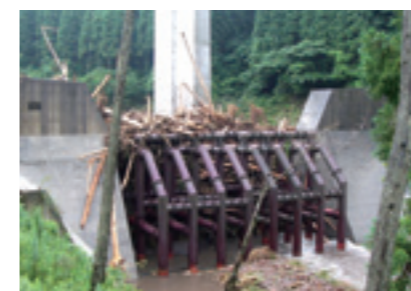
土石流・流木を捕捉する鋼製透過型えん堤
