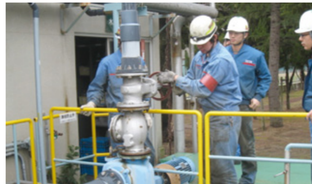
▲新人を対象とした工場排水異常訓練(茨木工場)
