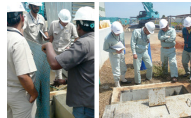
◀油水分離槽管理状況の確認
