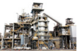
▲製鉄ダストのリサイクルプラント
