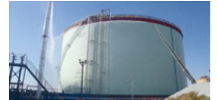
▲LPGタンクへの放水訓練
