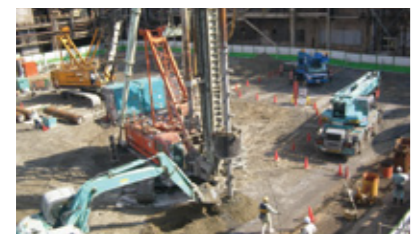
▲加古川製鉄所に建設中の自家発電所 (旧設備を撤去し、基礎工事中)
