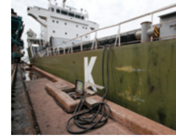
▼製鉄所での「陸電供給」
