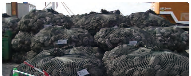
▲潜堤構築材（中詰材：スラグ石材）
