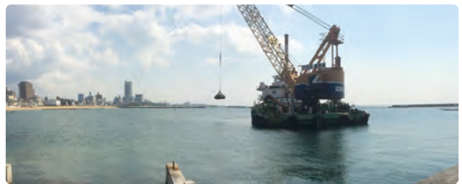
▲スラグ石材設置現場（須磨海岸沖）
