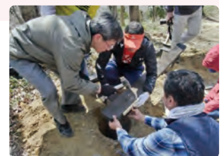
▲ ベンチ設置作業
