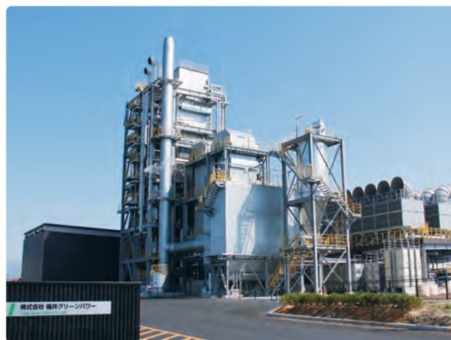
▲ 大野発電所(木質バイオマス発電設備)外観
