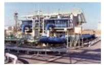
Open-rack LNG vaporizer
