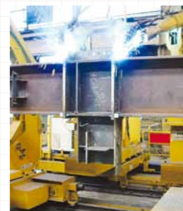
SRC 2-ARC welding
