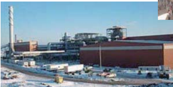
商業第1号プラントの全景
