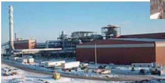
商業第1号プラントの全景
