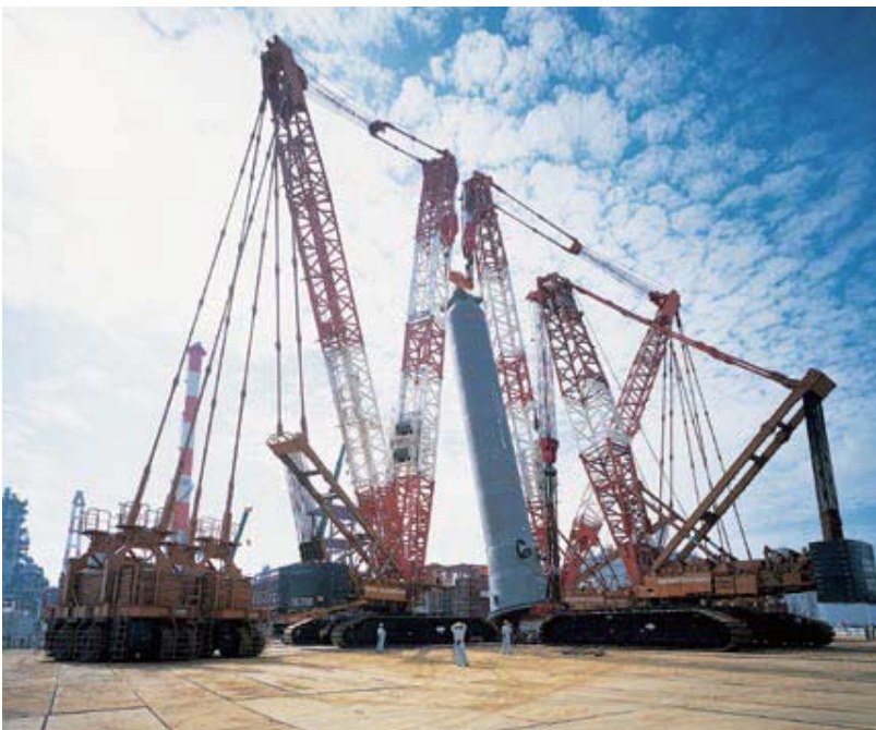
超大型クローラクレーン
