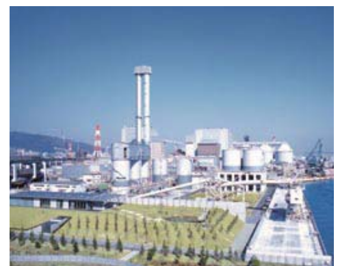
神鋼神戸発電所
