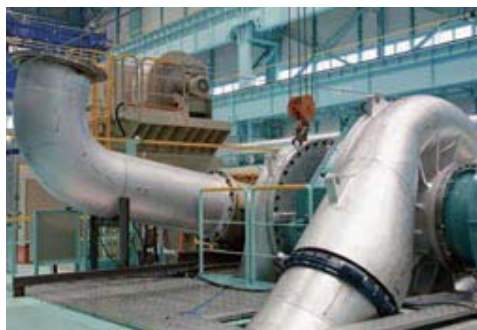
大型ターボ圧縮機の試運転風景
