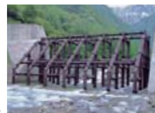
五十沢川砂防えん堤(新潟県)
