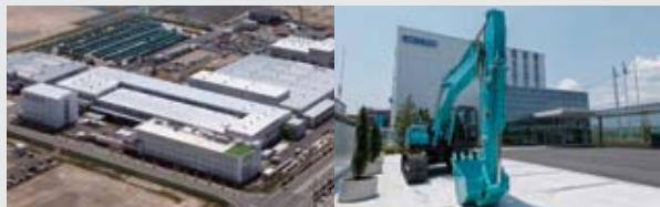
グローバル・エンジニアリング・センターおよび五日市工場
