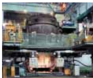
連続铸造設備
