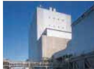
神鋼神戸発電所
