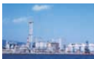
神鋼神戸発電所
