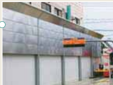
高性能アルミ製吸音パネル 「アルミ箔エコキューオン」を使用した防音壁
