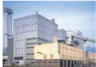
神鋼神戸発電所(タービン棟)
