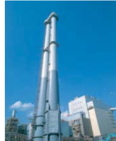
神鋼神戸発電所
