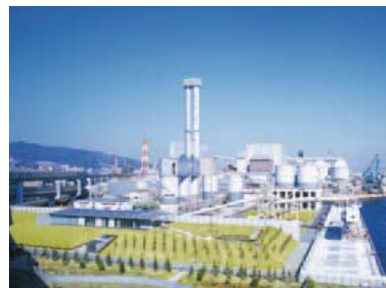
神鋼神戸発電所
