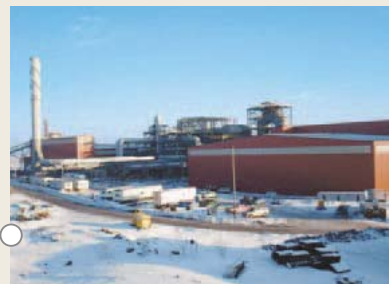
商業第1号プラントの全景
