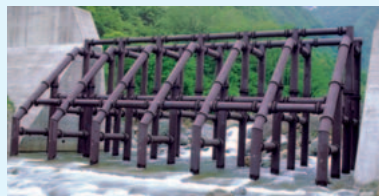
鋼製砂ろえん堤
