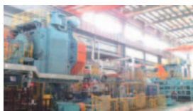
6,300トンメカニカルプレス外観
