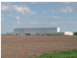
営業運転を開始した連続焼鈍設備 (CAL) 外観
