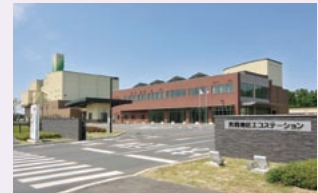
芳賀地区エコステーション
