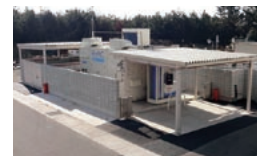
水素ステーション総合テストセンター
