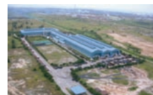
Kobelco Millcon Steel Co., Ltd. 工場
